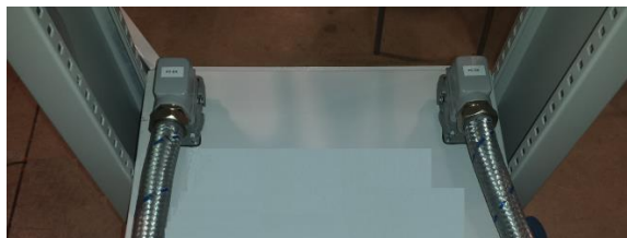
Figura 6 - conectorii laterali ai echipamentului
